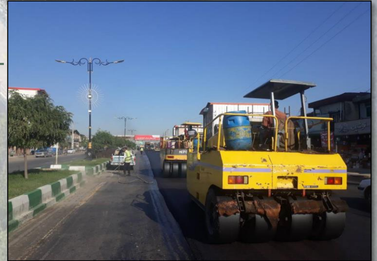
لکه‌گیری و روکش آسفالت بزرگراه جلین، قرق و خانبین
