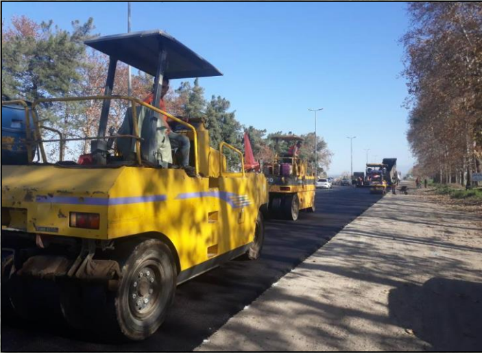
لکه‌گیری و روکش آسفالت بزرگراه جلین، قرق و خانبین
